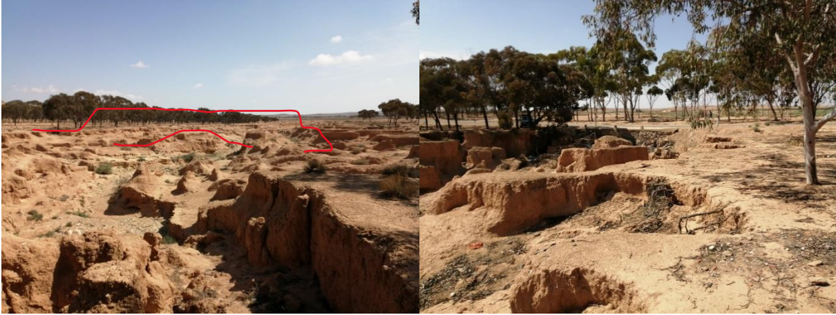
الصورة رقم 11: طريق مهددة بسبب التعرية التراجعية، الطريق الرابطة بين حامة قطيطر والطريق الوطنية 6
