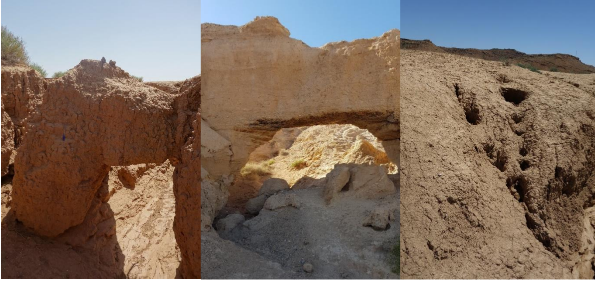
الصورة رقم 19: انهيار كتل كبيرة ومهمة بفعل التعرية الباطنية الجوفية، وجسور معلقة شاهدة قريبة من الانهيار
