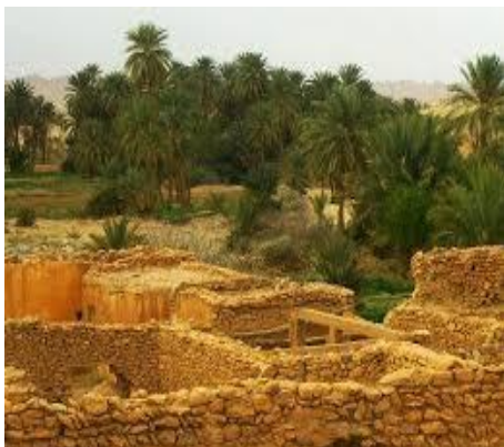
الصورة 08: منظر خارجي لأثار قصور صحراوية منهارة.
